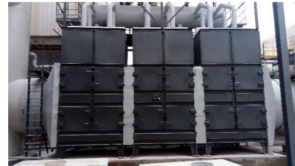
廃熱ボイラー
